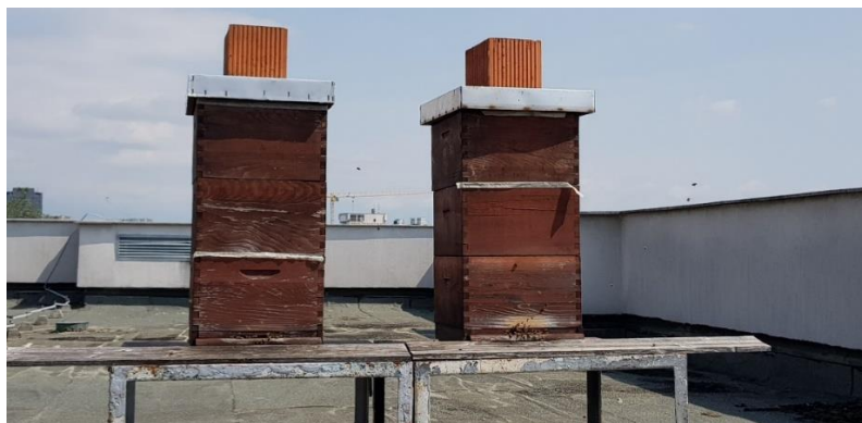
Slika 84: Čebelja panja sta nameščena na strehi šole
